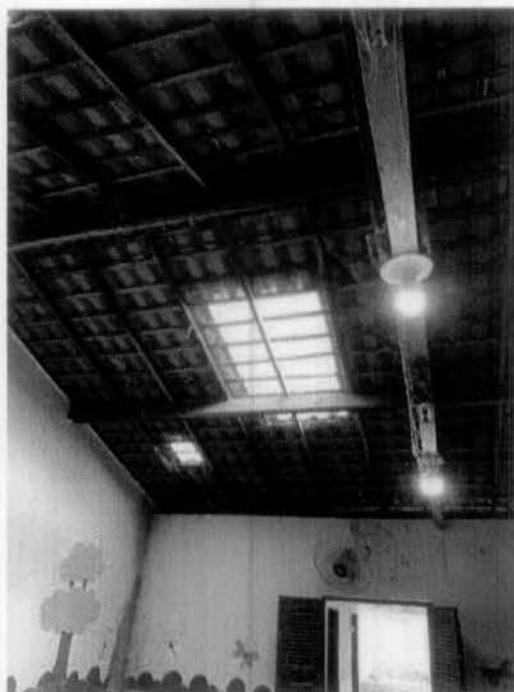
*Imagem 10 – Instalação de telhas translúcidas nas salas.*
