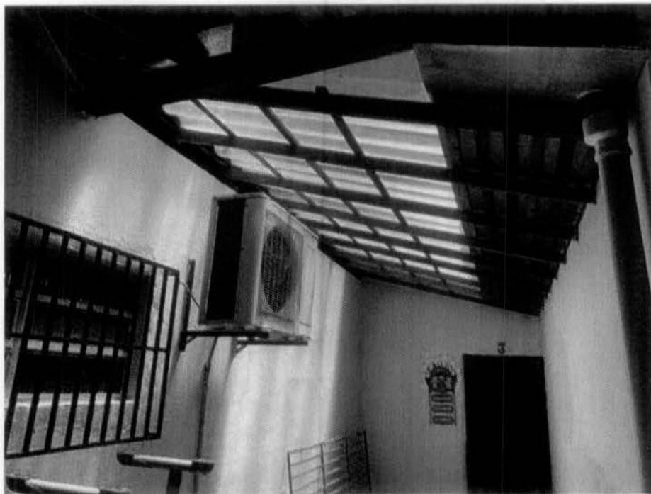
*Imagem 20 – Instalação de telhas translúcidas na circulação.*
